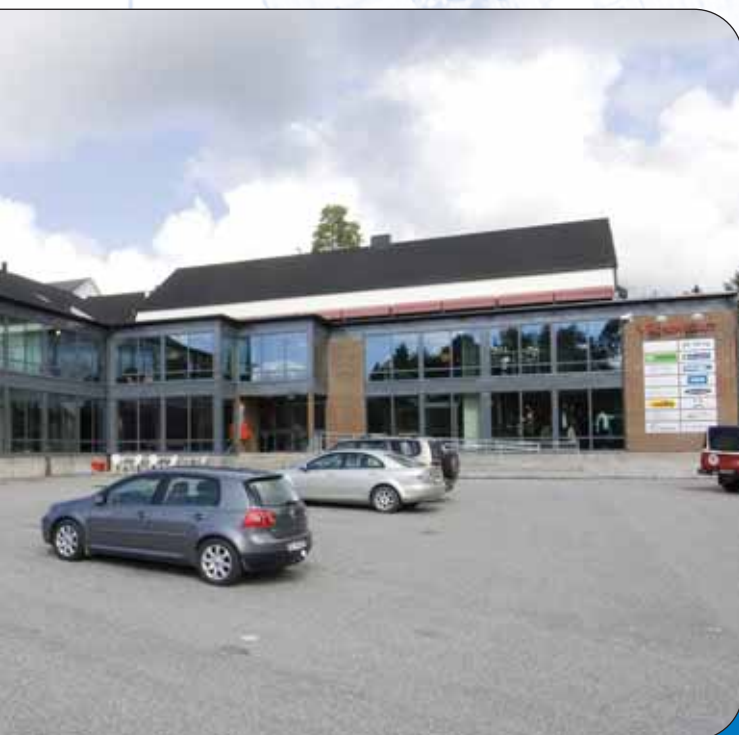
Ombygging og totalrehabilitering av Vågsenteret, Ytre Enebakk
