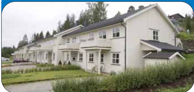
Rekkehus, Gjøstigen, Ytre Enebakk
